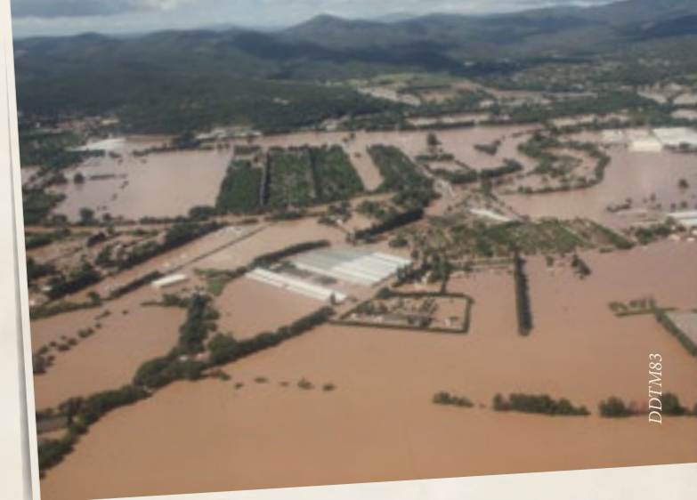
▲ La basse vallée de l'Argens sous les eaux
